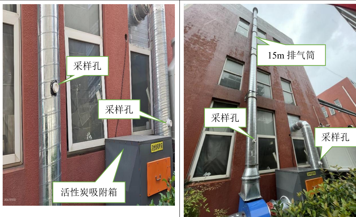
图 3.4 注塑废气治理设施照片
