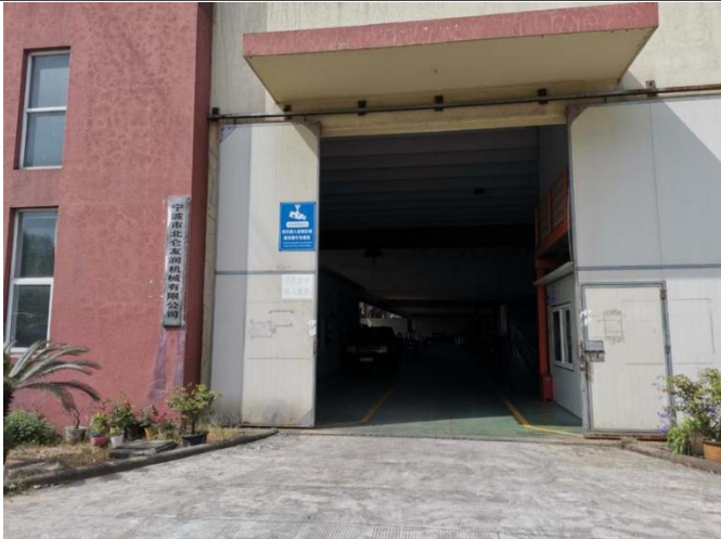
北侧（宁波市北仑友润机械有限公司）
