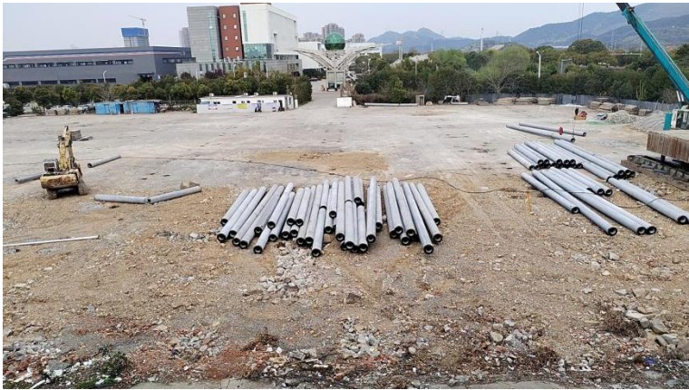
东侧（在建厂房）
